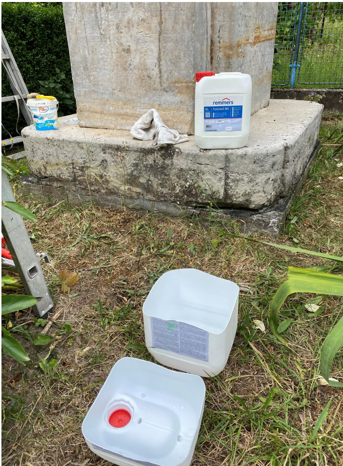
BĚLÁ U JEVÍČKA – SOCHA SV. JANA NEPOMUCKÉHO --HYDROFOBIZACE MATERIÁLEM FUNCOSIL WS
